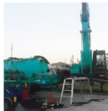
① セパレートboom 取り外し
