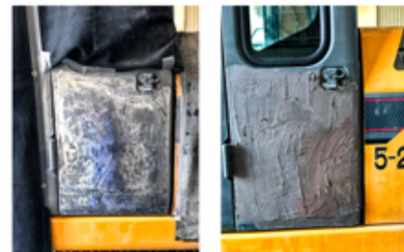
溶接作業が終了後、塗装部の磨きパテ作業を行います。
