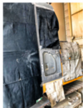
スパックシートで養生し、修正したパネルを溶接します。
