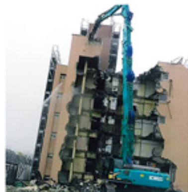
④ 現場組立、稼働
