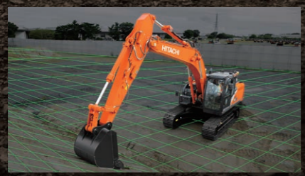
位置情報により掘削面を認識
