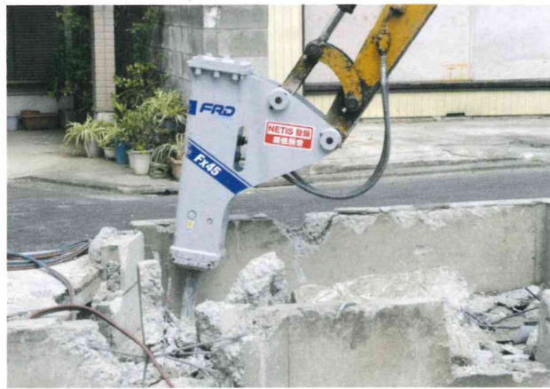
下町の家屋解体現場で活躍するF45 SS-box
