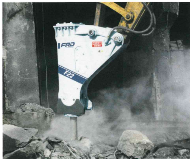
市街地のビル解体現場で稼働するF22 SS-box
